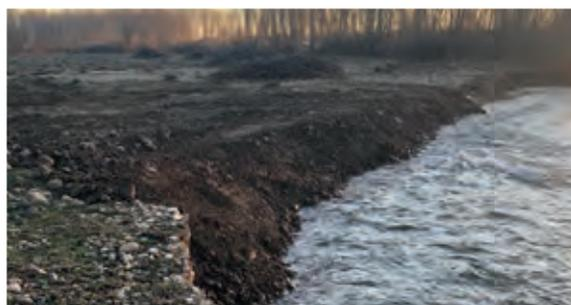
Consolidación de la escollera del talud en el cruce con el río Curueño de la aducción del río Porma
