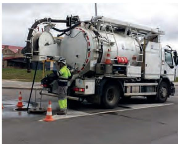
Mantenimiento de la red de alcantarillado con camión CIS
