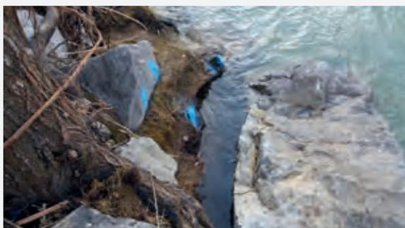
Rotura de la arteria entre depósitos debido a la crecida del río Bernesga
