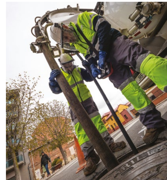
Trabajos de limpieza de la red de alcantarillado
