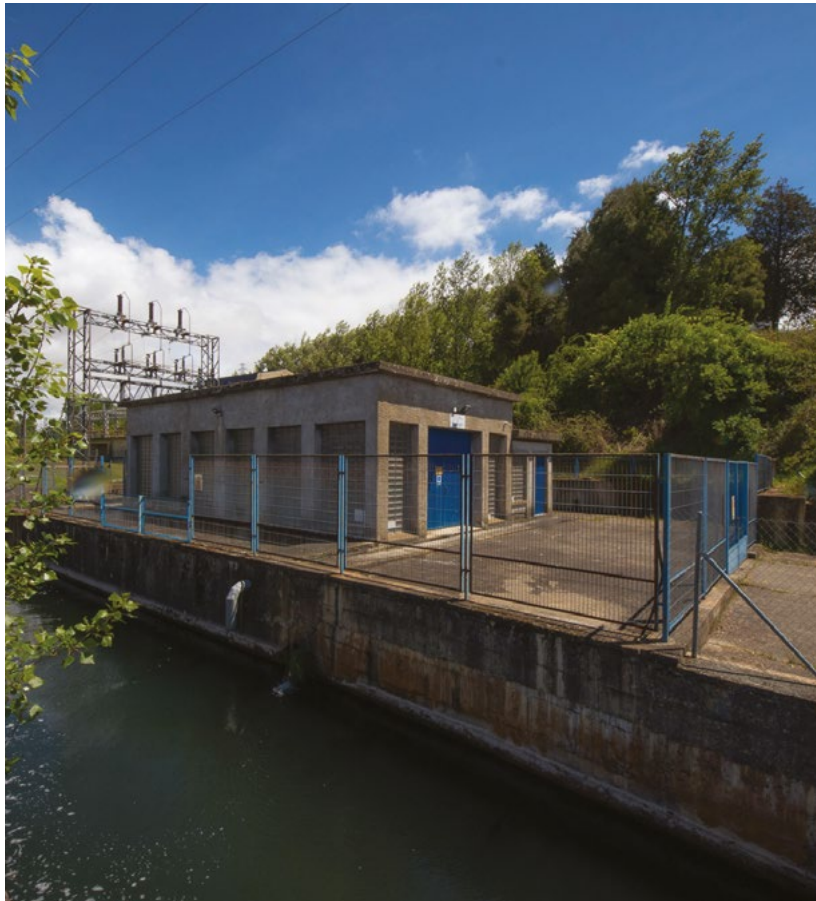
Estación de bombeo del sistema de abastecimiento de agua de León
