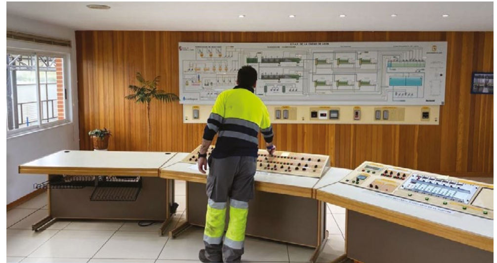
Operario de Aguas de León realizando trabajos en la ETAP.
