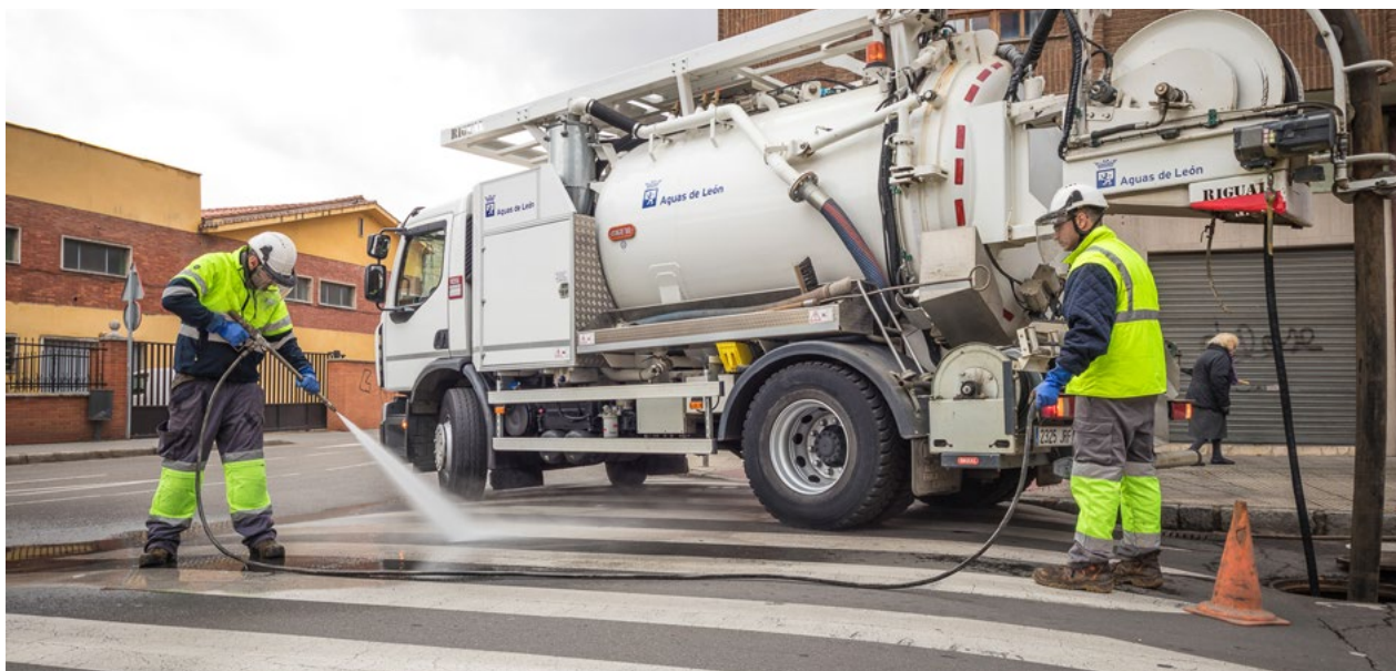
Trabajos de limpieza y mantenimiento del alcantarillado con camión CIS.
